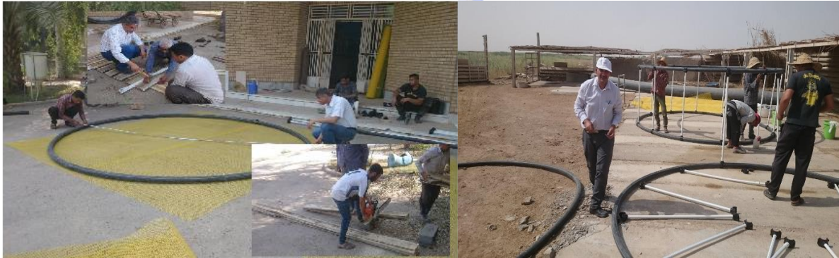
تصویر ۱) طراحی و ساخت قفسها با استفاده از لوله و اتصالات پلی اتیلن
